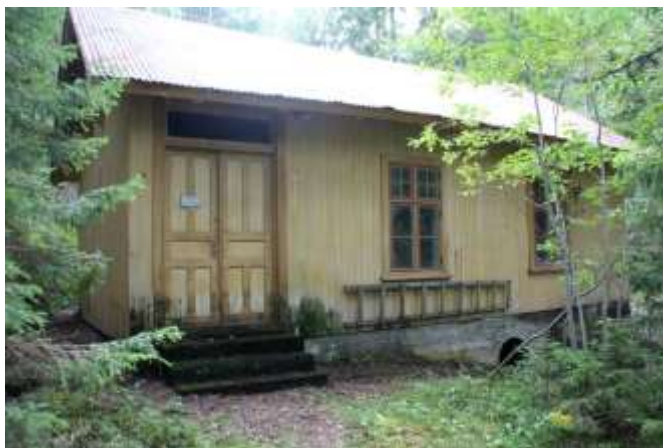
Kraftstasjonen slik den står i dag. Her er det behov for litt vøling.
