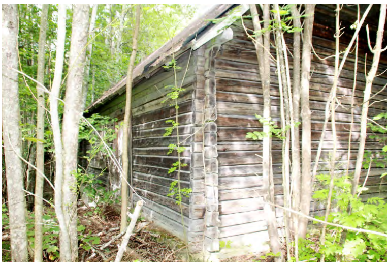
Kraftstasjonen slik den står der i dag omkransa av tett lauvskog.
